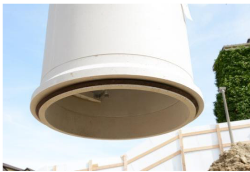
2. Kontrolle Dichtung
