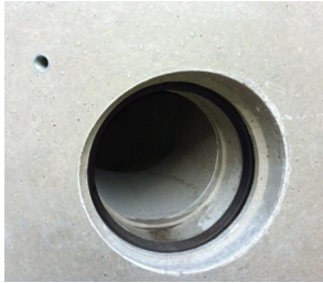
6. Muffendetail für Rohranschluss
