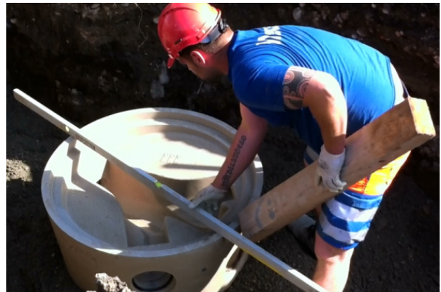
3. Kontrolle der Lage des Schachtbodens
