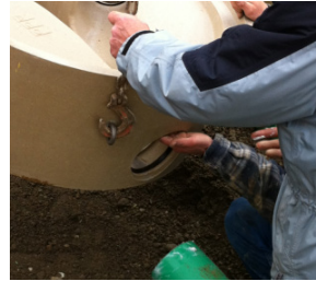
8. Aufbringen vom geeigneten Gleitmittel auf den Dichtungsring
