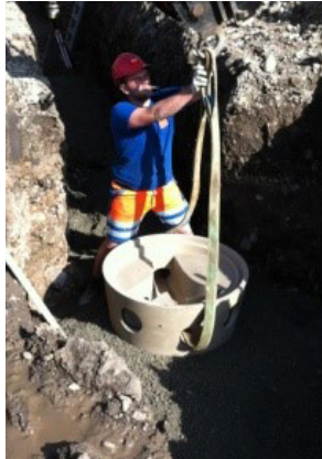
2. Versetzen Schachtboden auf horizontale Betonsohle
