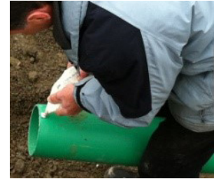
9. Aufbringen von geeignetem Gleitmittel auf dem Anschlussrohr
