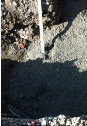
1. Vorbereiten der Grubensohle
