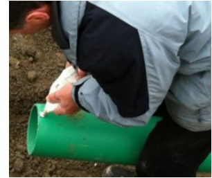
9. Aufbringen von geeignetem Gleitmittel auf dem Anschlussrohr
