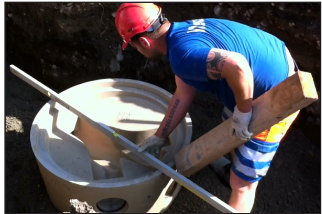
3. Kontrolle der Lage des Schachtbodens
