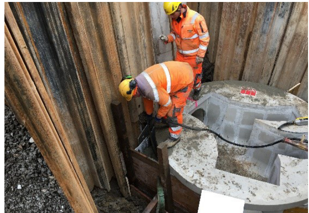
5. Verdichtung Unterfütterung
