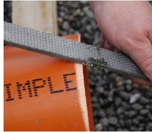
7. Anschleifen des Kunststoffrohres
