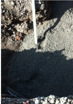
1. Vorbereiten der Grubensohle
