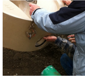
8. Aufbringen vom geeigneten Gleitmittel auf den Dichtungsring
