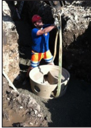
2. Versetzen Schachtboden
