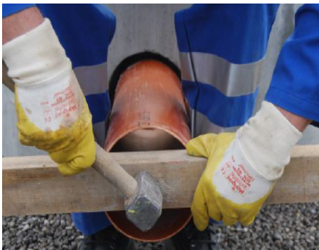
10. Zentriertes Ansetzen des Kunststoffrohres. Dichten des Kunststoffrohres je nach Witterung (Temperatur) mit einem kräftigen Hieb.
