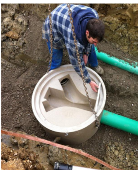
1. Schachtboden setzen
