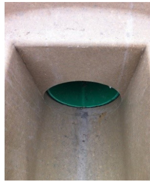
11. Optimaler Muffen spalt nach dem Einschub und Richten des Kunststoffrohres
